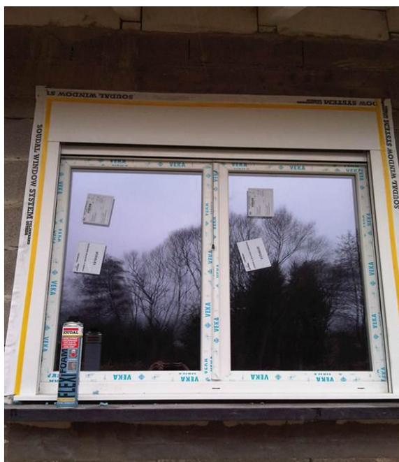
*Observación: conseguir unas juntas horizontales y verticales equilibradas y de igual grosor simplifica el sellado de las esquinas y evita tener que utilizar cintas de diferente anchura.*
