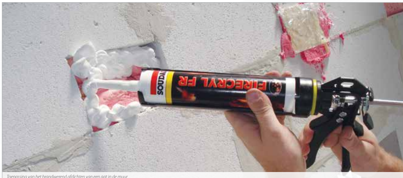
Toepassing van het brandwerend afdichten van een gat in de muur
